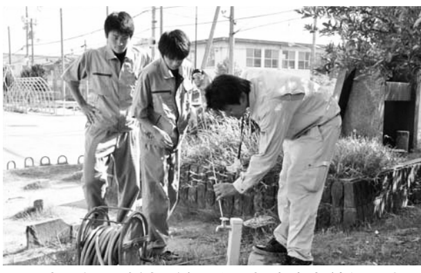
漏水の疑いがある個所に音聴棒を差し込む
